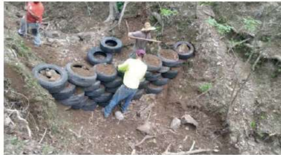
Imagen 14. Formación de una presa de llantas. Fuente: Ejido Tebelchia, mpio. Puerto Vallarta
