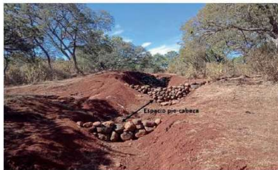
Imagen 16. Espaciamiento entre presas utilizando el criterio pie-cabeza Fuente: Comunidad Indígena de Mezcala, mpio. Poncitlán
