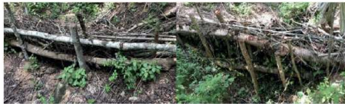
Imagen 11. Diseño de presa de ramas en cárcavas Fuente: Ejido Nacastillo, mpio. La Huerta
