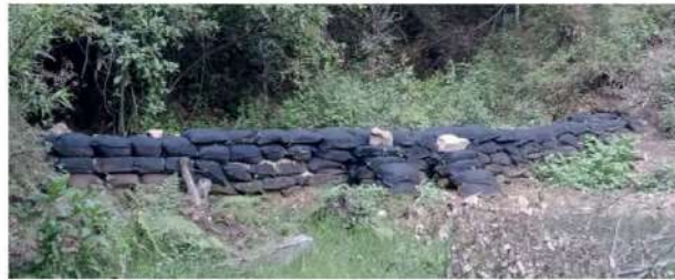
Imagen 13. Diseño de presa de geocostales. Fuente: Jorge Cruz, mpio. Tecalitlán
