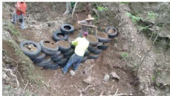
Imagen 13. Formación de una presa de llantas
