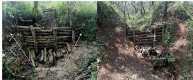
Imagen 10. Vista frontal del delantal en presa de morillos en áreas forestales Fuente: Ejido Tequesquiltán, mpio. Cuautitlán de García Barragán
