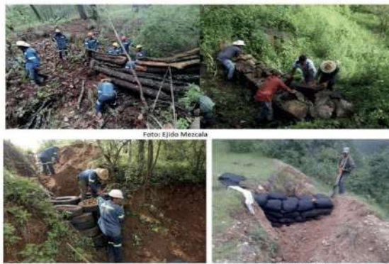
Imagen 19. Mantenimiento de presas Fuente: Georgina Cruz, mpio Tecalitlán y del Ejido Mezcala, mpio. Ayutla
