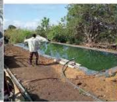
Imagen 9. Sistema para captación de agua; reservorio con geomembrana Fuente: Internet
