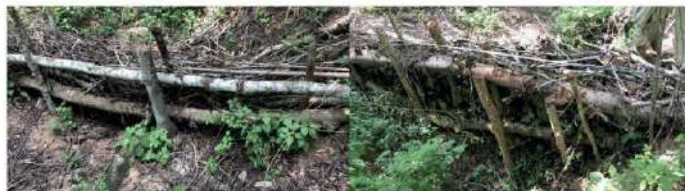
Imagen 8. Diseño de presa de ramas en cárcavas Fuente: Ejido Nacostilla, mpio. La Huerta
