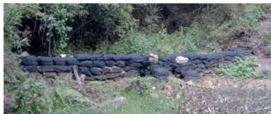
Imagen 12. Diseño de presa de geocostales Fuente: Jorge Cruz, Mpio. Tecalitlán
