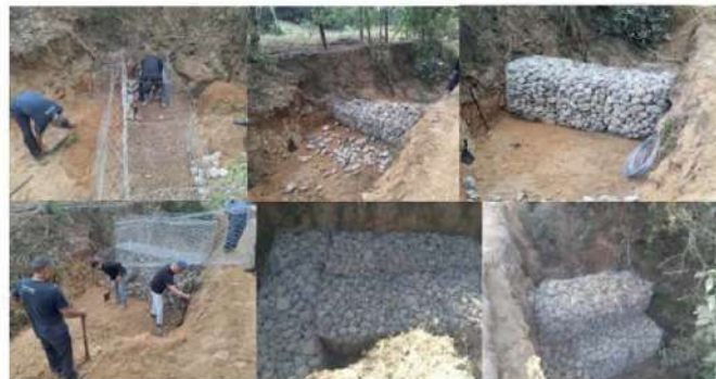
Imagen 14. Formación de estructuras de presas de gaviones rellenas de piedra acomodada Fuente: Ejido Soyotari, mpio. San Sebastián del Oeste
