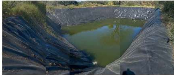
Imagen 20. Olla de agua revestida con geomembrana Fuente: Jorge Robles, mpio. Zapotitlán de Vadillo
