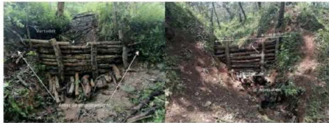
Imagen 7. Vista frontal del delantal en presa de morillos en áreas forestales Fuente: Ejido Tequesquite, mpio. Cuautlán de García Barragán
