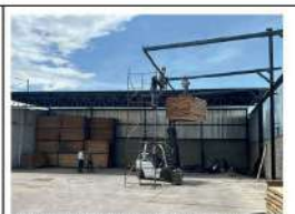
Imagen 4. Construcción de techo metálico Fuente: Productos Forestales Gomal, S.A. de C.V.
