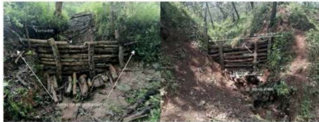
Imagen 9. Vista frontal del delantal en presa de morillos en áreas forestales Fuente: Ejido Tequesquitián, mpio. Cuautitlán de García Barragán
