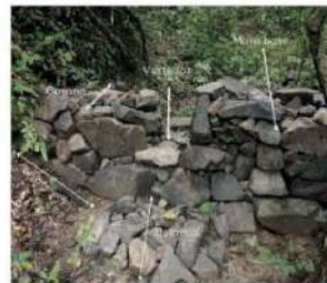
Imagen 11. Partes que constituyen una presa de piedra acomodada Fuente: Ejido Casimiro Castillo y Ejido el Rincón, mpos. Casimiro Castillo y La Huerta
