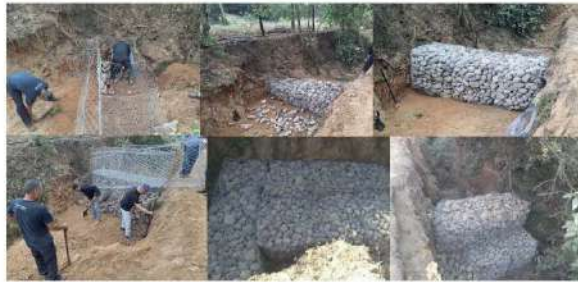
Imagen 15. Formación de estructuras de presas de gaviones rellenas de piedra acomodada
