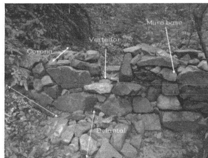
Imagen 12. Partes que constituyen una presa de piedra acomodada. Foto: Ejido Casimiro Castillo y Ejido el Rincón.
