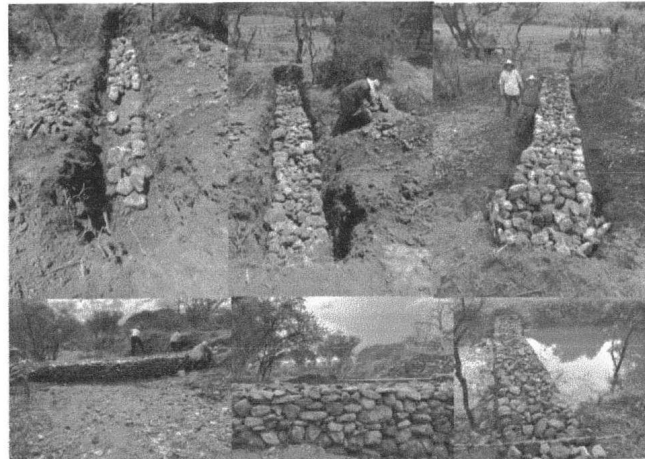
Imagen 14. Formación de estructuras de presas de gaviones rellenas de piedra acomodada Fotos: Juan Zenaído, Mpio. Colotlán.
