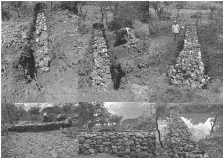
Imagen 15. Formación de estructuras de presas de gaviones rellenas de piedra acomodada.
