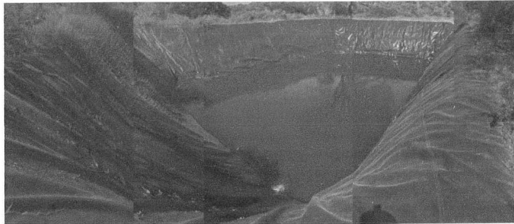
Imagen 20. Olla de agua revestida con geomembrana Foto: Jorge Robles, Mpio. Zapotitlán de Vadillo.
