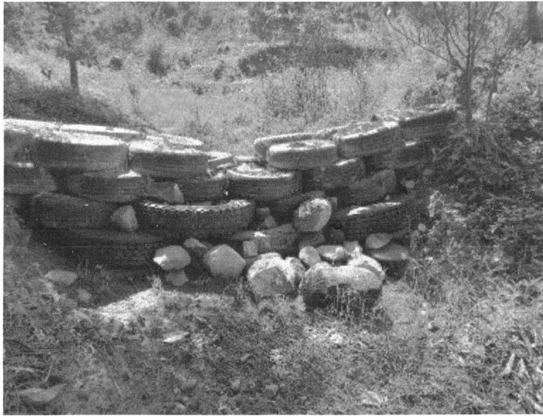
Imagen 13. Formación del vertedor en una presa de llantas Foto: Ejido Purificación.
