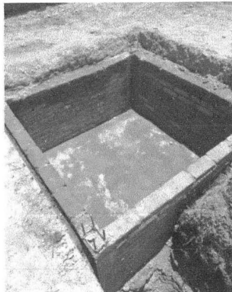
Imagen 19. Contenedor para almacenar agua.
