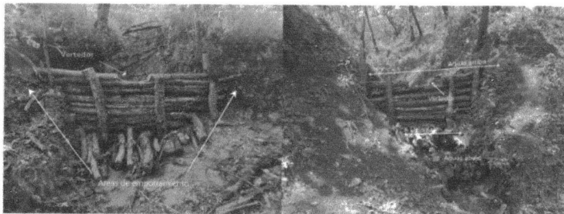
Imagen 10. Vista frontal del delantal en presa de morillos en áreas forestales. Foto: Ejido Tequesquiltán.
