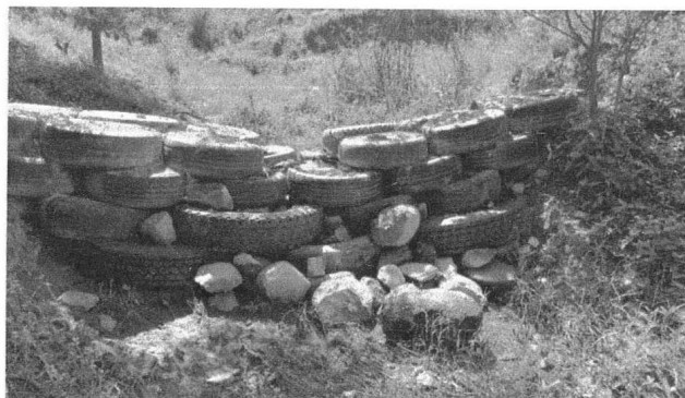
Imagen 14. Formación del vertedor en una presa de llantas. Foto: Ejido Purificación.
